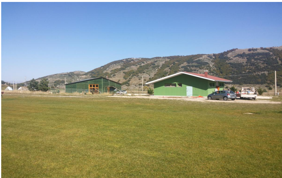
Strutture di supporto al Campo da Calcio – Spogliatoio - Palestra
